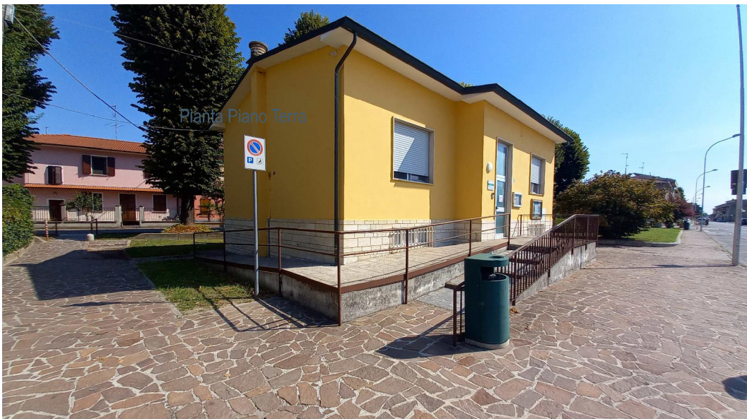
Accesso all'ambulatorio tramite rampa dal parcheggio dedicato
