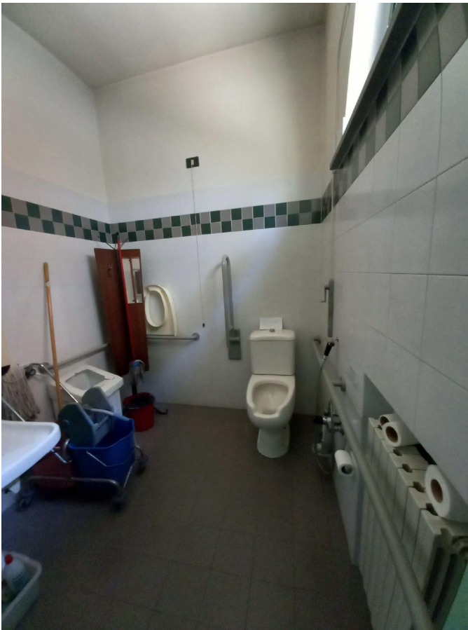
Dettaglio servizi igienici
